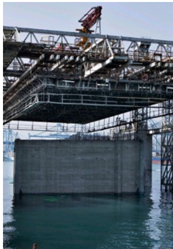
Cajón preparado para la botadura.
