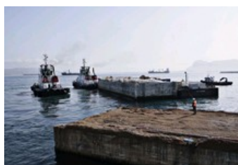
Maniobra de traslado del cajón a su ubicación definitiva.
