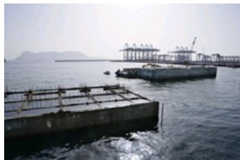
Cajones fabricados para la construcción del muelle.
