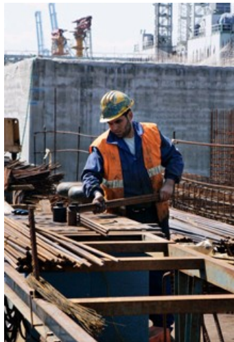
Operario en el parque de ferralla.
